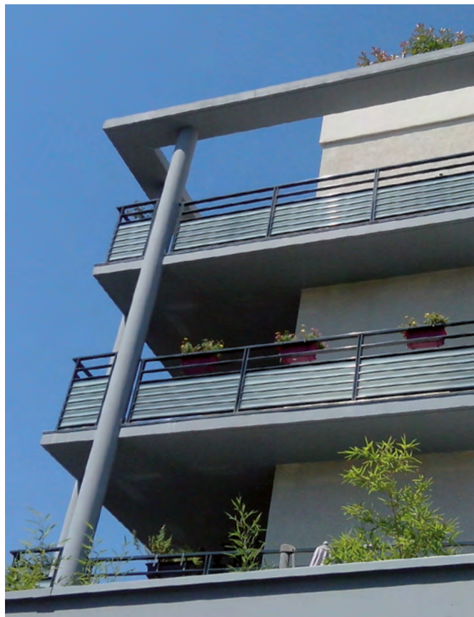
FERIA avec une lisse intermédiaire, vitrage 44/2 opale et option lisses décoratives.
