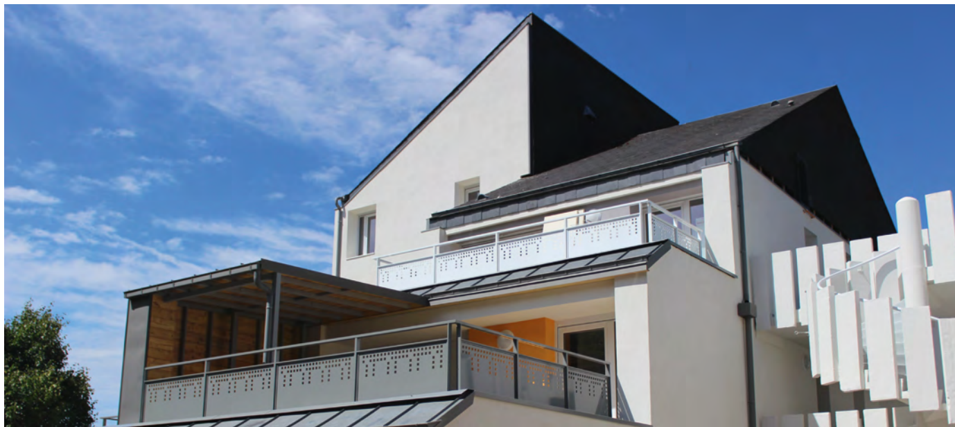
FERIA vide sous main courante avec remplissage en tôle découpée laser.
